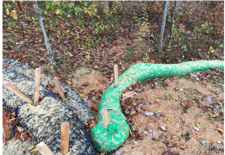
Fig. 20: STA 14904+00 – Sediment off ROW.
