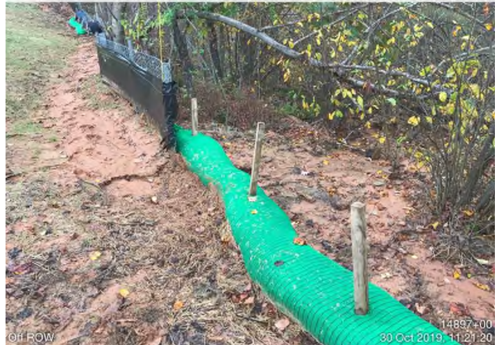
Fig. 20: STA 14904+00 – Sediment off ROW.
